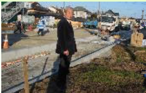
都市計画道路 双柳岩沢線工事(岩沢地内)
